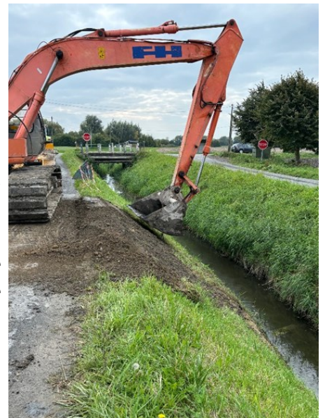
Réfection des berges- L'Ebillaix à Cherrueix
